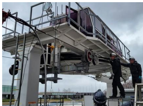
山麓原動滑車のゴムライナー交換
